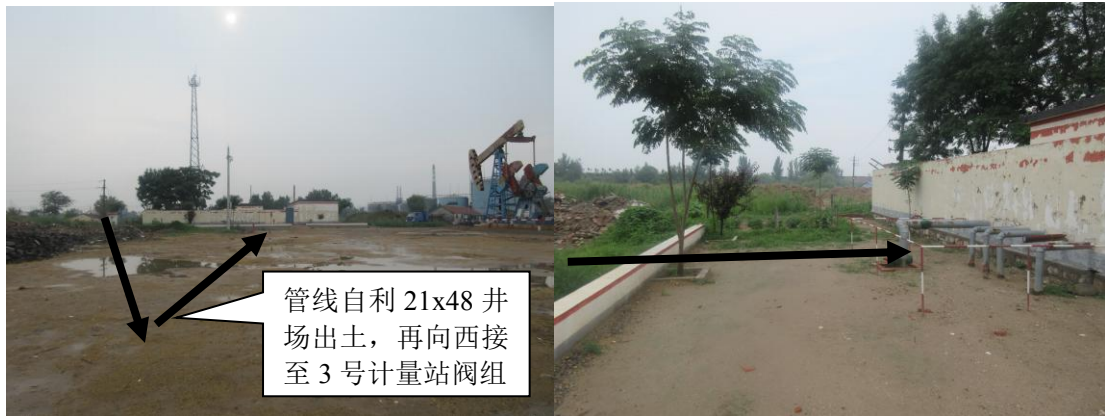
图 5.2-2 新建利 3 号站注水管线定向钻段现场示意图
