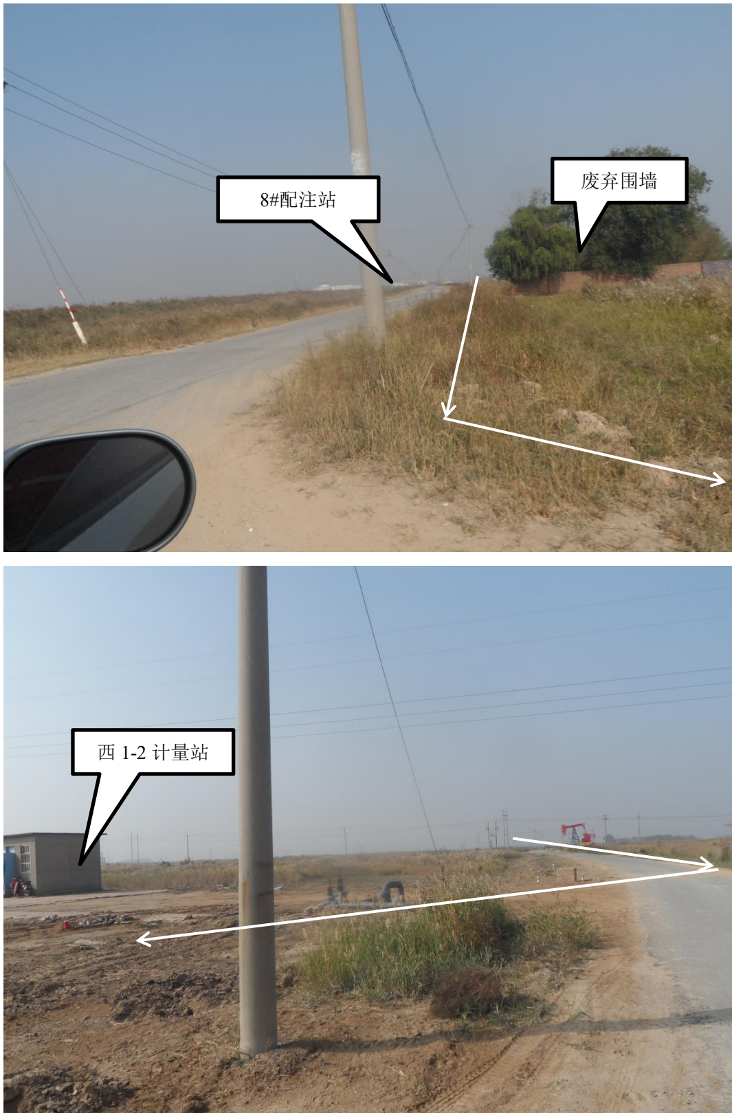
图 5.1-3 管线现场情况图
